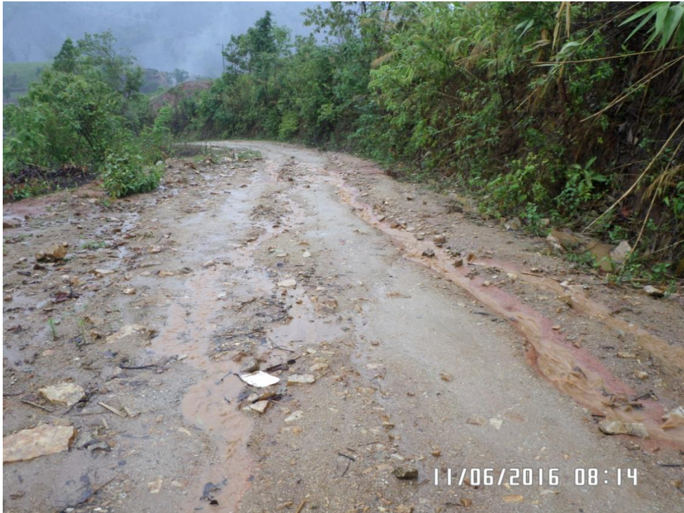
ภาพประกอบ 63 ถนนถูกน้ำฝนกัดเซาะ และน้ำป่าไหลหลาก มีก้อนหินแหลมคม
