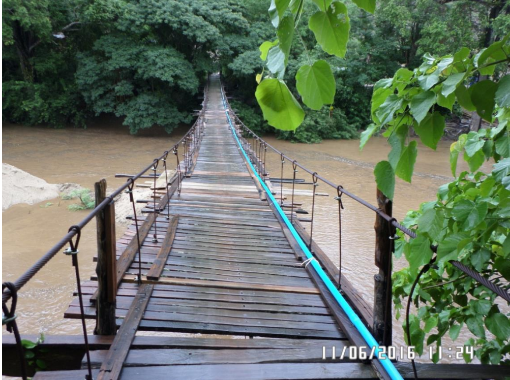
ภาพประกอบ 64 สะพานลวดสลิงข้ามแม่น้ำ
