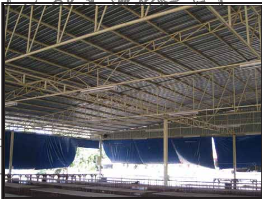
ภาพที่ 4 แสดงลักษณะภายในโครงหลังคาตลาดนัดหนองหอย
