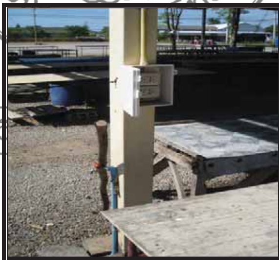
ภาพที่ 22 แสดงระบบน้ำ ระบบไฟฟ้า ตามจุดต่างๆ ทั่วทั้งตลาดนัด 16 จุด
