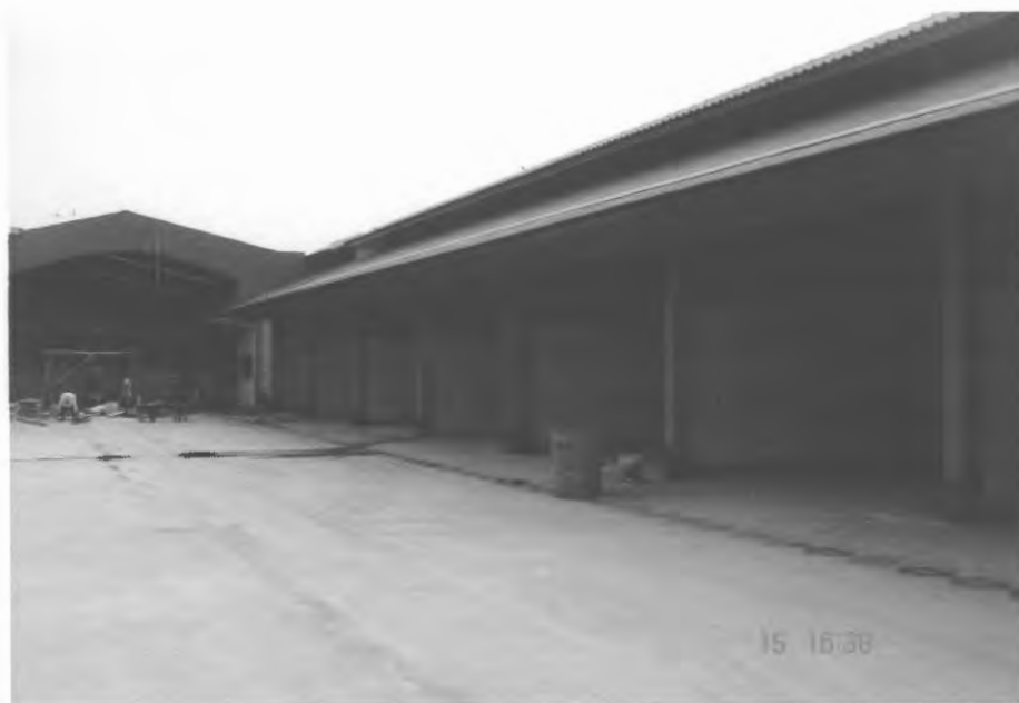
ภาพที่ 2 ลักษณะทั่วไปของโรงแรมที่กำลังก่อสร้างในโครงการที่ 2
