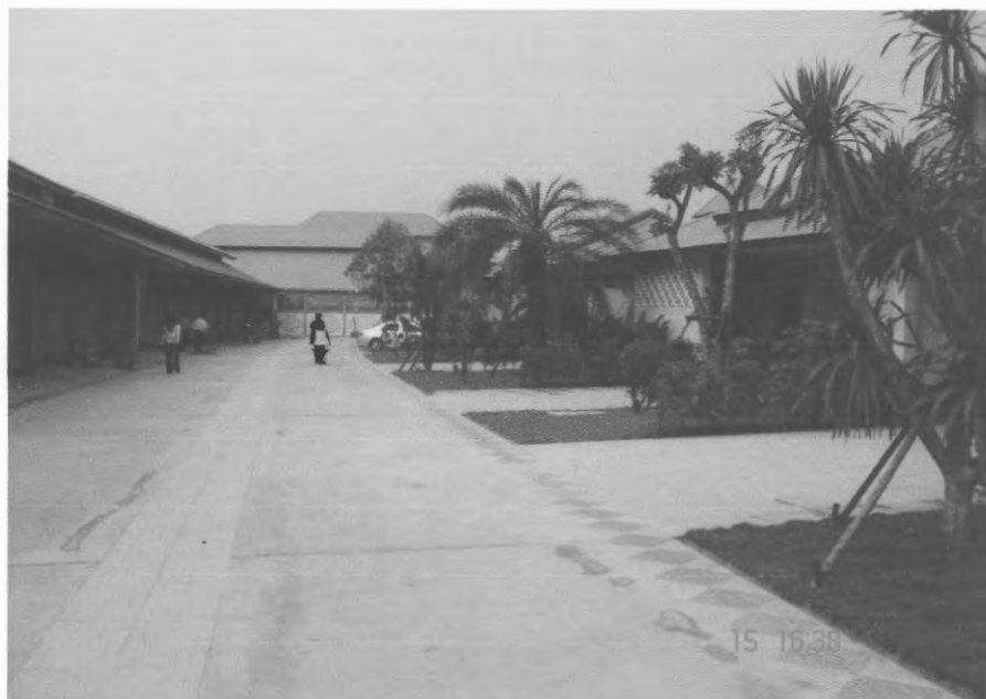
ภาพที่ 3 ลักษณะทั่วไปของโรงแรมที่กำลังก่อสร้างในโครงการที่ 2
