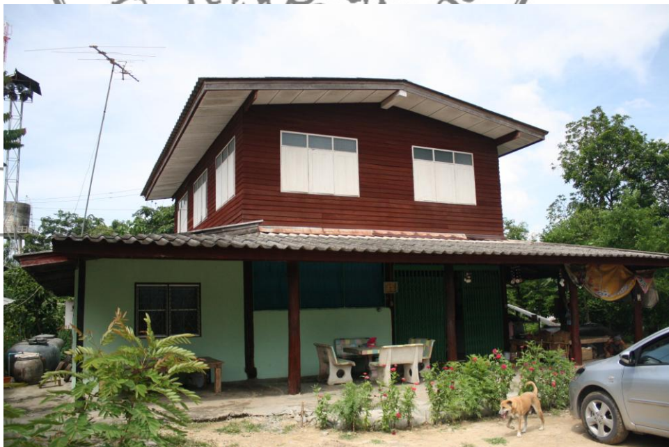
ภาพที่ 2 บ้านของชาวไทดำที่เป็นแบบครึ่งปูนครึ่งไม้สองชั้น ไม่มีใต้ถุน
