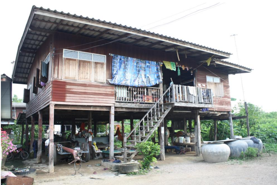
ภาพที่ 1 บ้านของชาวไทดำเป็นบ้านไม้ ยกใต้ถุนสูง มีหน้าต่างเพิ่มมากขึ้น และหลังคาปูกระเบื้อง
